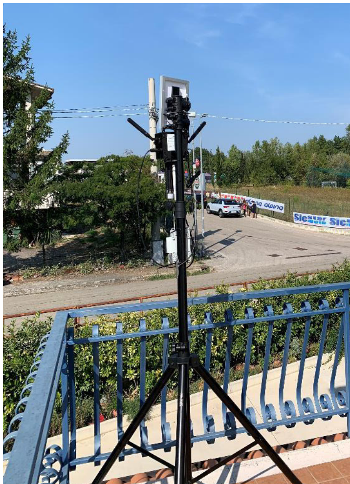
Figura 6: Posizione di installazione centralina Libelium equipaggiata con sensori e pannello solare
